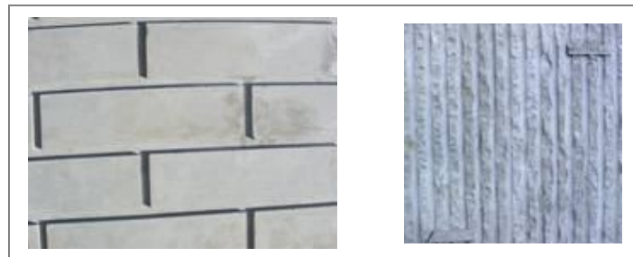
Figura 1. Diferentes terminaciones superficiales en Hormigones
