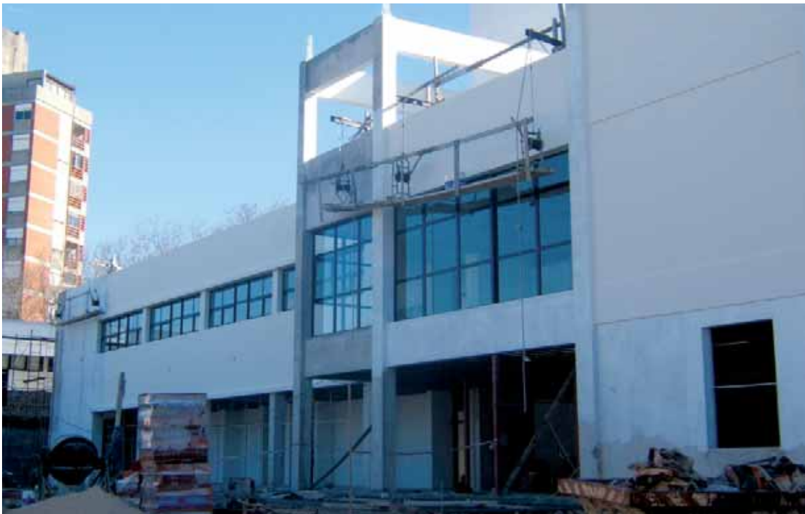
▼ Vista desde patio central
