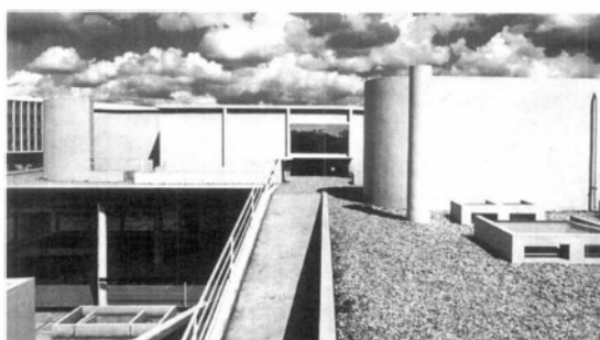
Casa sobre el arroyo, Mar del Plata, Pcia. de Buenos Aires. Amancio Williams, arq.
