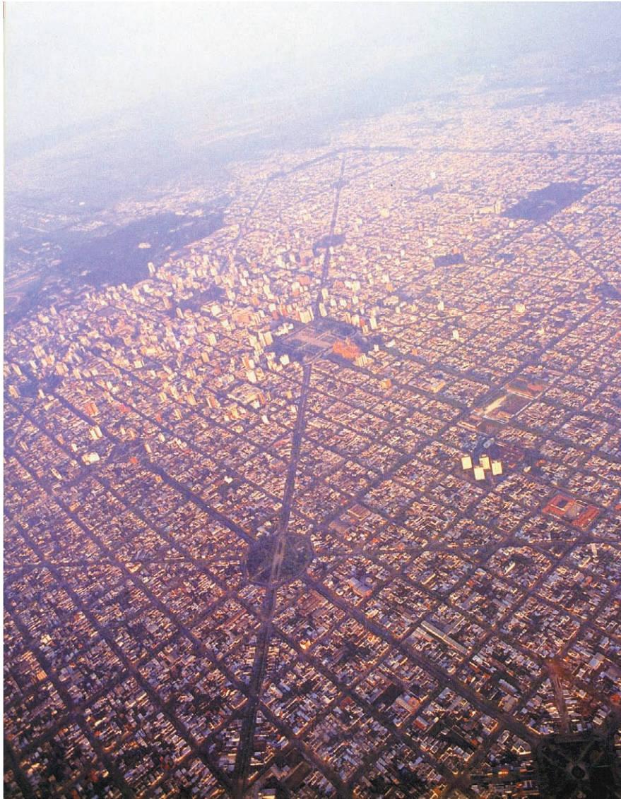
Foto 1. Aérea en perspectiva sobre diagonal 73. Municipalidad de La Plata.
