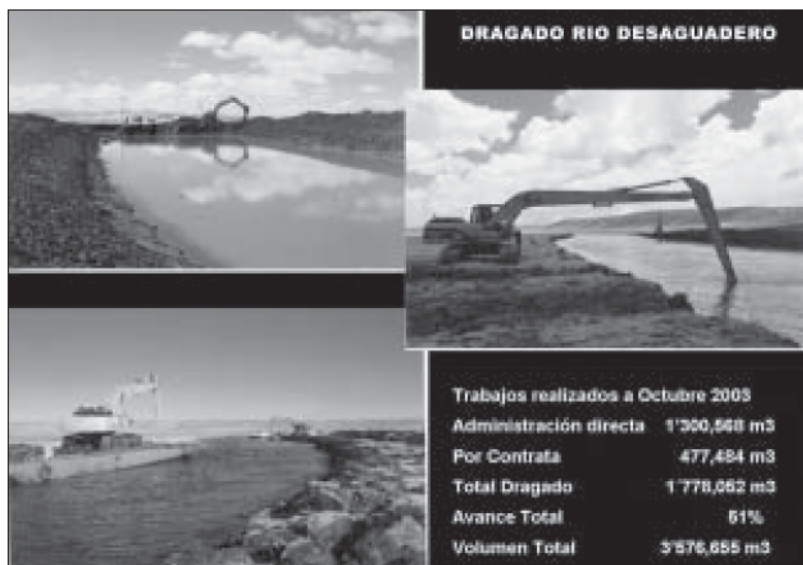
Figura 4 Dragado río Desaguadero
