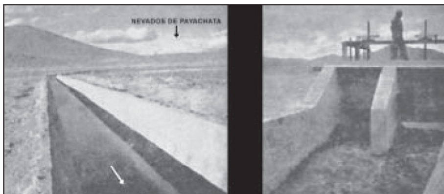
Kilómetro 20 del canal Lauca en la zona altiplánica chilena.
