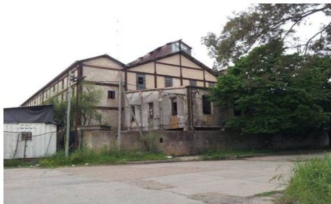
Figura 39. Edificio ex Usina eléctrica. Patrimonio industrial de nuestra ciudad, memoria del trabajo, constituye un referente de la arquitectura industrial de la Región. El sistema constructivo y lenguaje arquitectónico fue pergeñado a mediados del siglo XIX por los ingleses y exportado al mundo. Está realizado con piezas íntegramente construidas en taller. Tanto en su estructura como en sus cerramientos, el acero ha reemplazado al hierro fundido. Este, por entonces novedoso, sistema constructivo se manifiesta en el exterior con un depurado lenguaje. Fuente: Margueliche, Juan Cruz. Año 2012.
