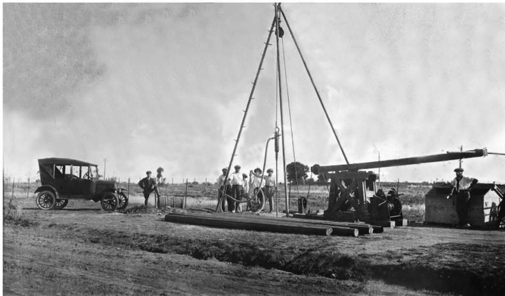
3. Perforación del pozo para extraer agua en el Parque San Martín.
