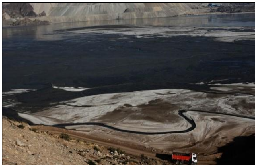
Figura 2.7. Dique de colas, sitio de almacenamiento de los residuos producidos en la etapa de concentración.
