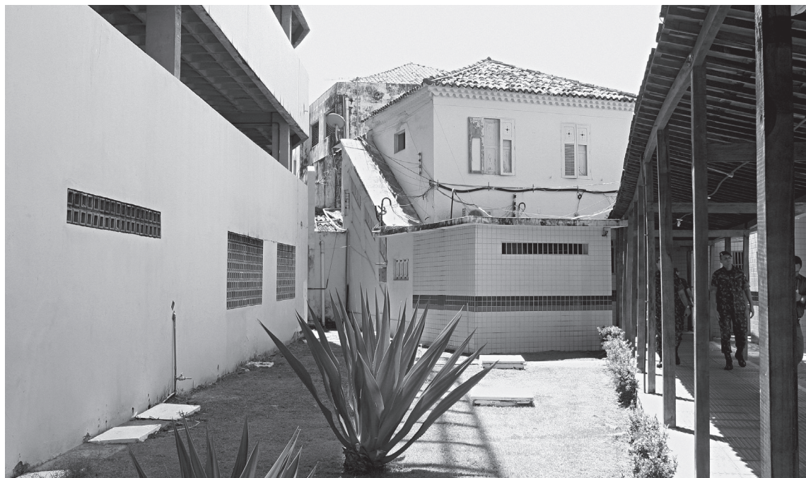
Edificação com faixa de azulejos, ao centro, dificulta o acesso ao prédio original do DOI-CODI do IV Exército, local apontado como de prática de tortura. Fonte: Arquivo CNV
