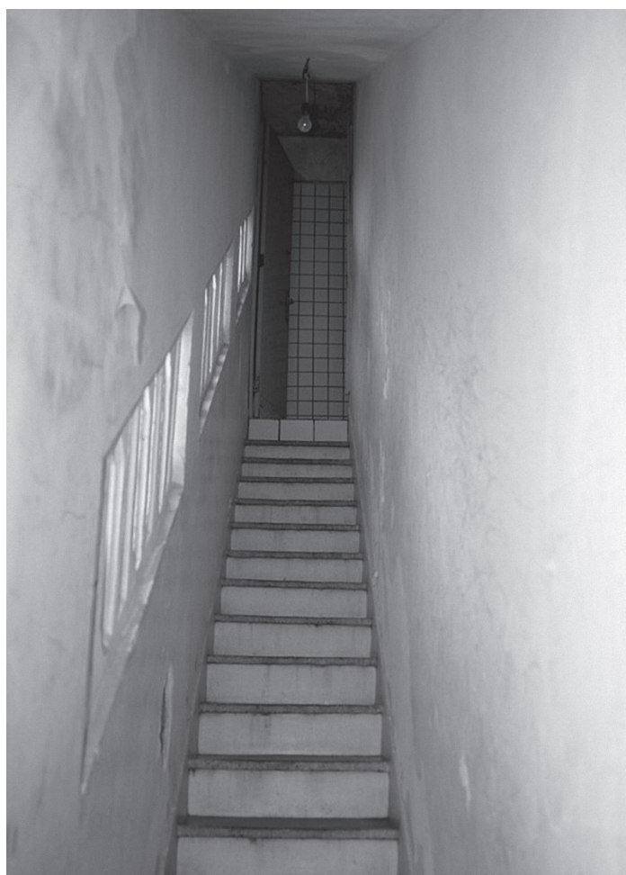
Escada de acesso ao prédio reconhecido por ex-presos políticos como local de tortura. Fonte: Arquivo CNV
