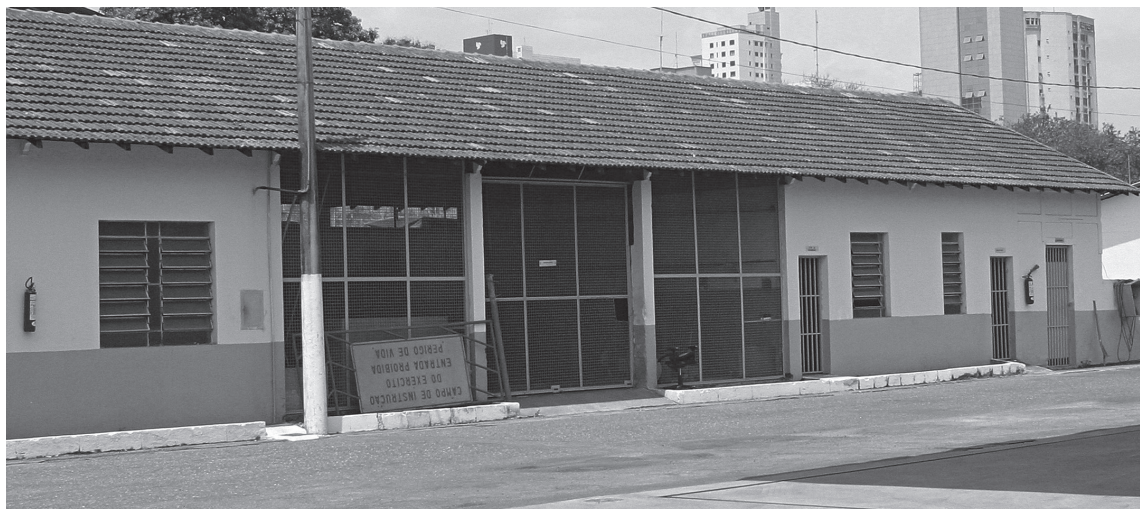
Via interna, em alicive, com acesso ao pátio do pelotão de manutenção e transporte do quartel do 12º Regimento de Infantaria do Exército, em Belo Horizonte, reconhecido por ex-presos políticos como local onde foi praticada tortura. Fonte: Arquivo CNV
