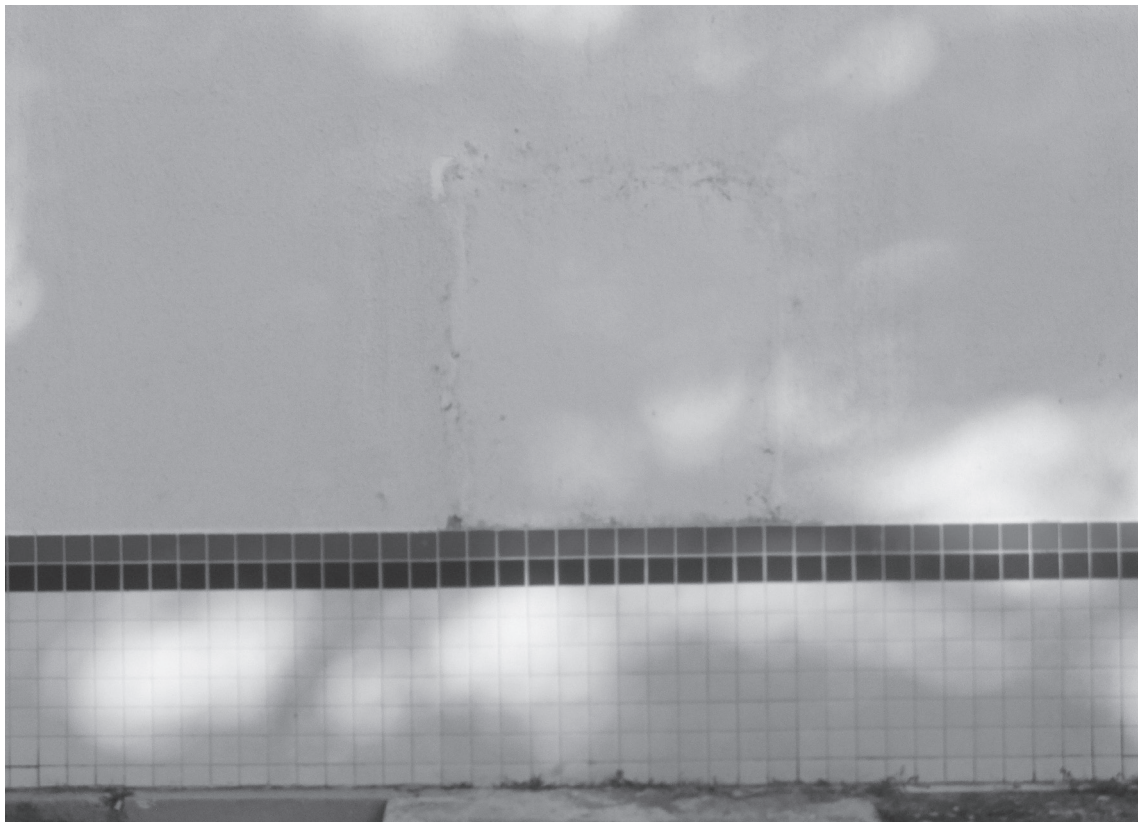
Detalhe de vão de porta fechado pela reforma, na fachada posterior da edificação. Fonte: Arquivo CNV
