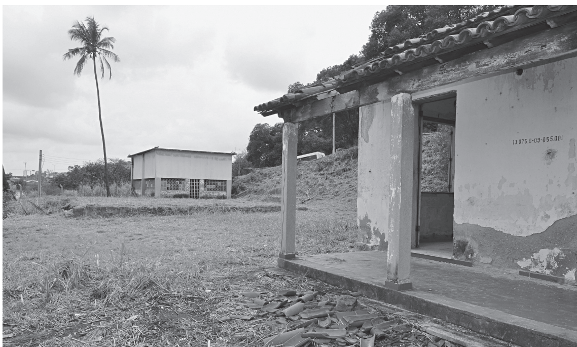
Casa de máquinas. Dos dois locais indicados pelas testemunhas, um deles foi completamente demolido. Fonte: Arquivo CNV
