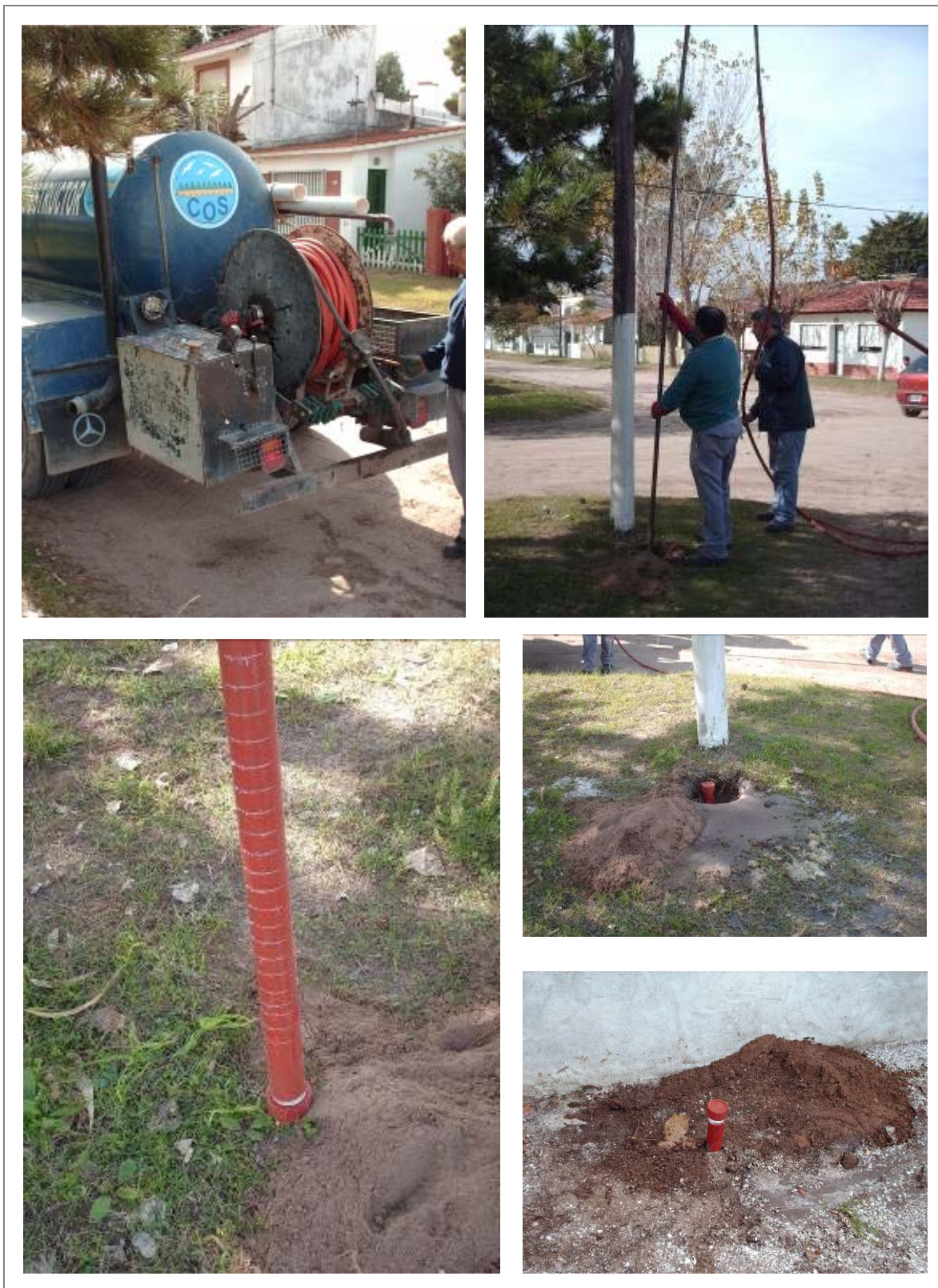
Figura 2.10. Colocación de los freáticos.
