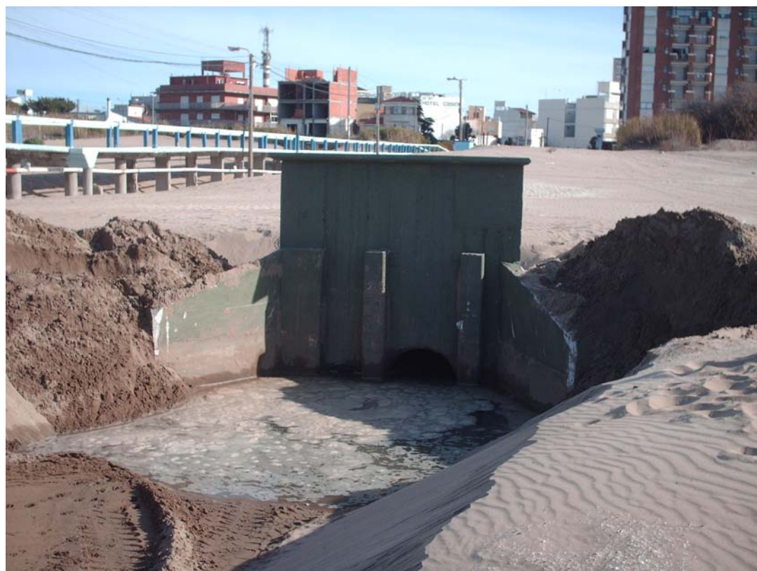
Figura 6.9. Desagüe que termina en la playa, donde posteriormente el flujo se conduce al mar.
