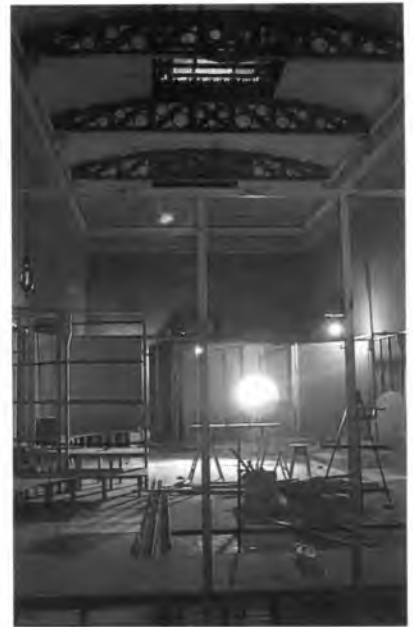
Montaje de infraestructura.
