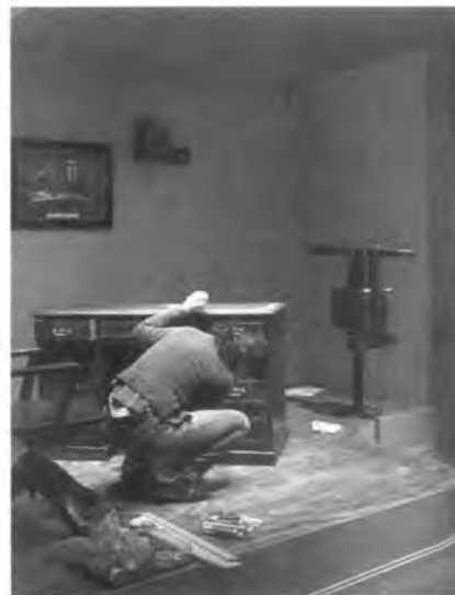
Montaje del gabinete.
