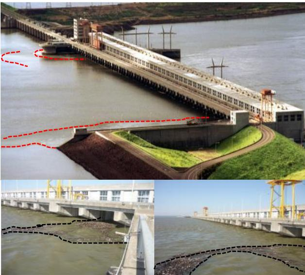
Figura 4: Fotografías de la zona de recirculación y de acumulación de flotantes en la central actual.
