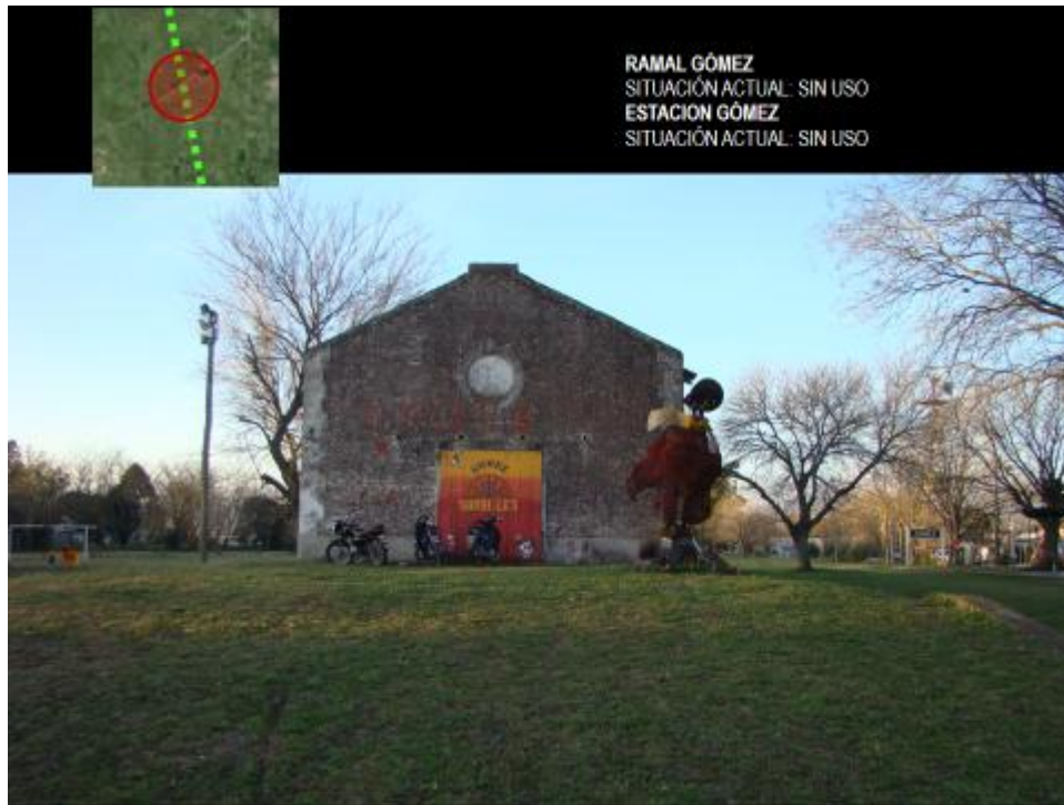
Figura 15: Estación Gómez como espacio de arte
