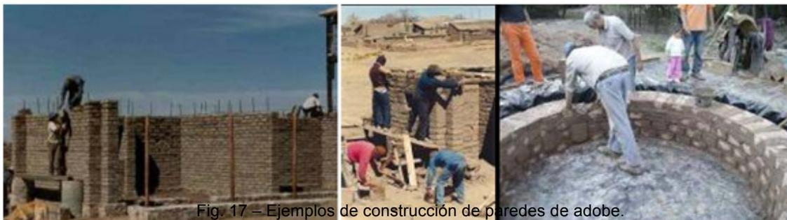
Fig. 17 – Ejemplos de construcción de paredes de adobe.
