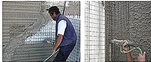
Fotografía 36. Aplicación microhormigón en paredes verticales
