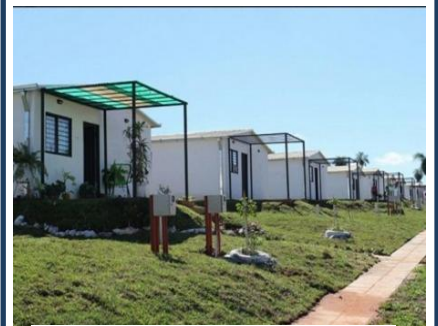
Viviendas con sistemas
