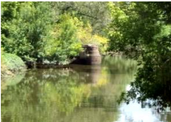
Foto N°8: Muro de contención Fuente: Imágenes del autor
