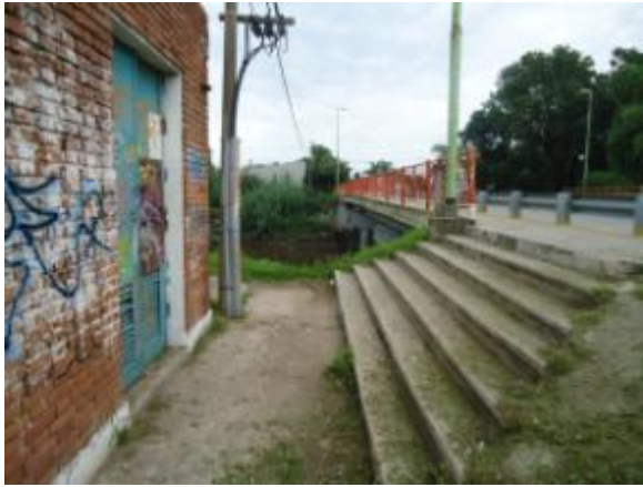
Foto N°2: Ex fábrica AGA Fuente: Imágenes del autor
