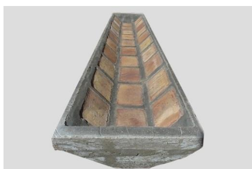
Fig.16- Módulo autoportante, Techo Batea
