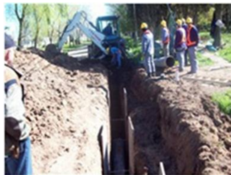
Figura 2: Ampliación red de desagües Guernica, Bs. As.
