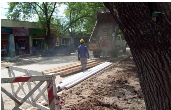
Fig. 15: Descarga y acopio de materiales en la vía pública. OI
