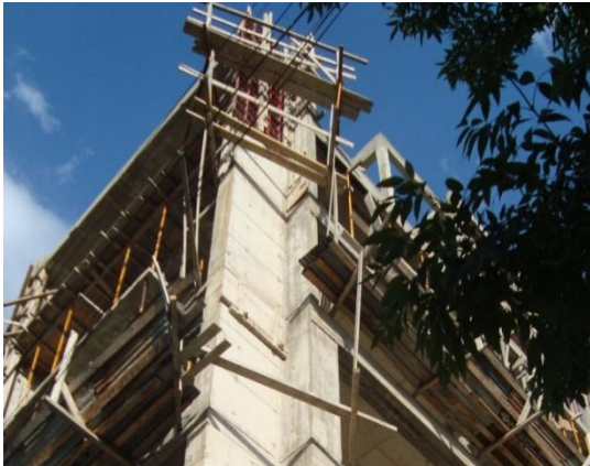
Fig. 7: Bandejas de protección en 4° y 6° nivel. PH1
