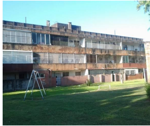
Fig. 8. Monobloque con fachada de orientación norte.
