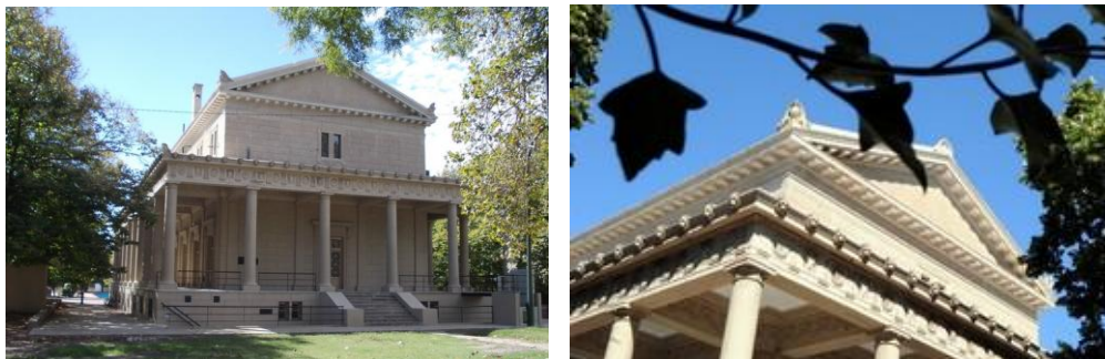
Imagen 8 y 9: Fotografías de la situación actual. Fachada NE y detalle.
