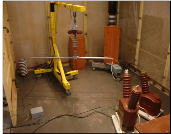
Figura 12.- Foto de la instalación de prueba
