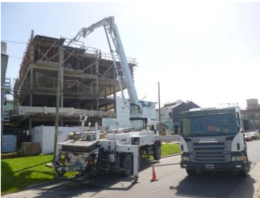
Imagen 24: hormigonado con pluma. Fuente: http://transgrues.blogspot.com.ar/
