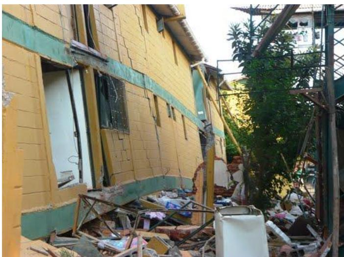
Fig.1 Colapso primer piso de albañilería bloques de hormigón
