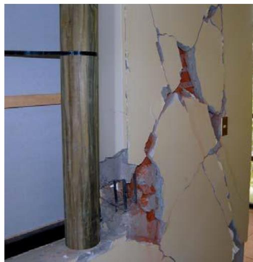
Fig.2 Daños en muros de albañilería confinada
