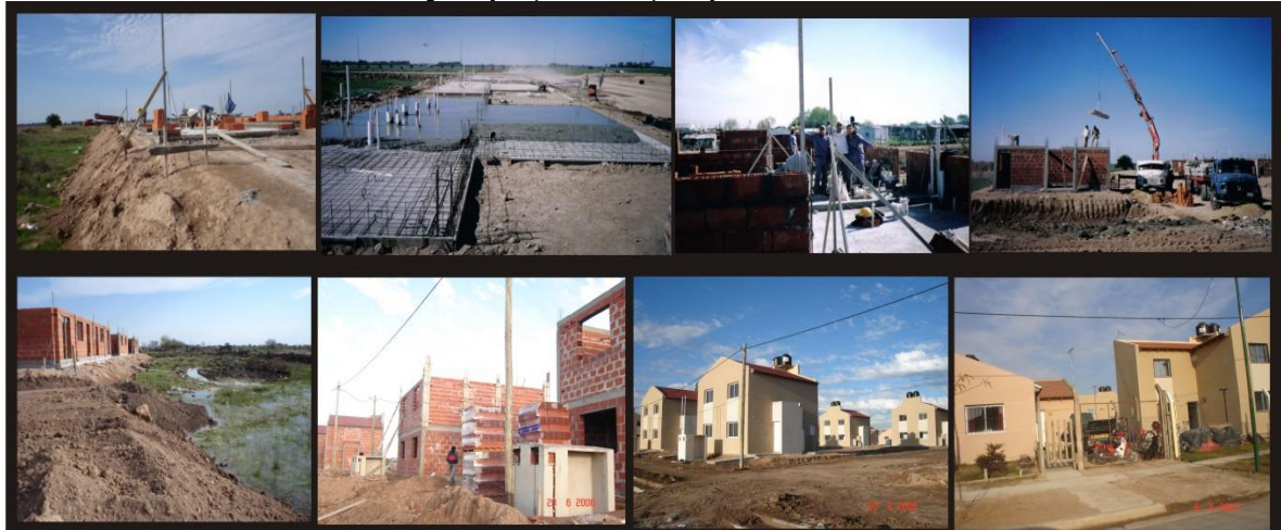
Fig. 6: Proceso de construcción de viviendas. El Mercadito. Documentación fotográfica Marsili-Massa Formica.
