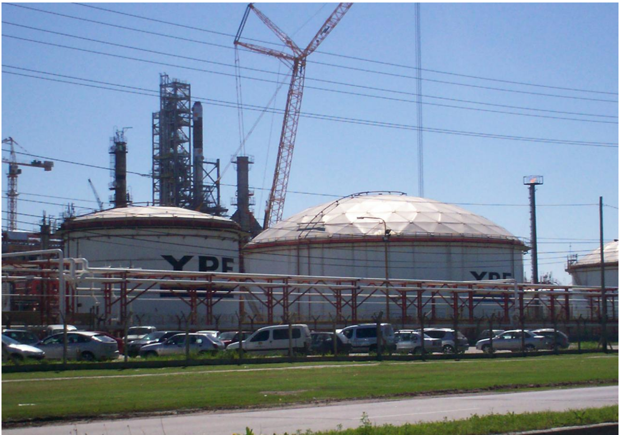
Destilería YPF- La Plata (Fuente: trabajo de campo 2014)
