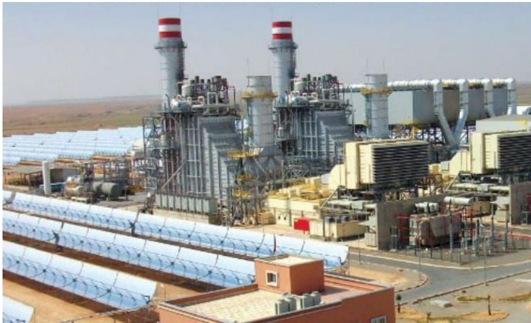
Figura 1.7. Central híbrida solar gas Ain Beni Mathar
