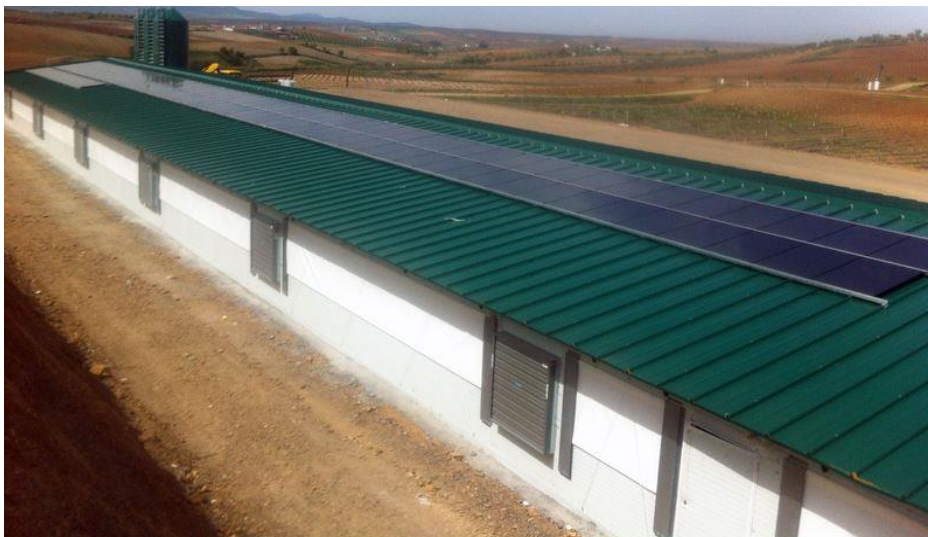
Figura 1.12. Paneles fotovoltaicos en granja avícola (PV Magazine, 2014)
