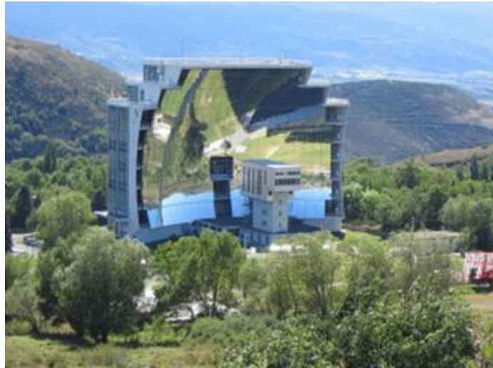
Figura 4.5. Foto del Horno Solar de Odeillo-Font Romeu, edificio del laboratorio PROCédés, Matériaux et Énergie Solaire (PROMES-CNRS)
