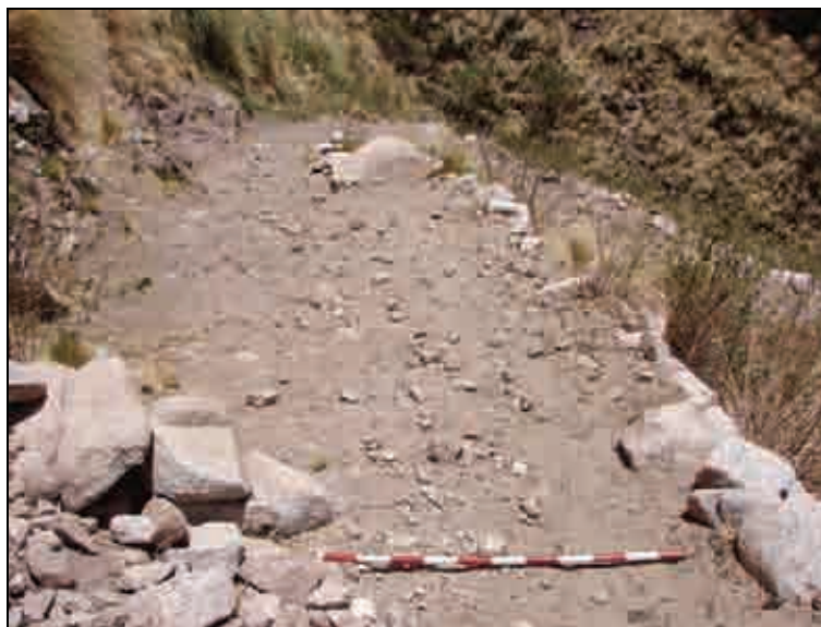
Figura VI.145. Camino de descenso de la altiplanicie en dirección a Mal Paso. Diseño en zigzag con talud y excavación dentro de la ladera. En la esquina inferior izquierda de la imagen se pueden observar los restos de un derrumbe. Fotografía del autor.
