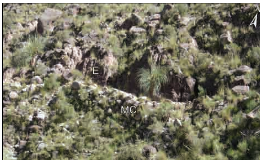
Figura VI.184. Otro segmento del camino con talud y excavación que desciende del Abra de La Ramadita: MC= muro de contención o talud ladera abajo; E= excavación dentro de la ladera. Fotografía del autor.
