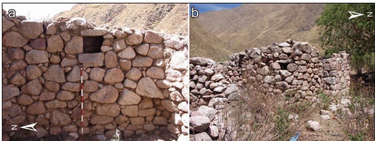
Figura VI.154. Puesto Sacha Uva: a) Vista exterior de una de las habitaciones del puesto; b) Vista interior de otra habitación. En ambos casos se puede observar la presencia de hornacinas. El pircado es doble, con mortero y calzado con lascas (piedras más pequeñas).
