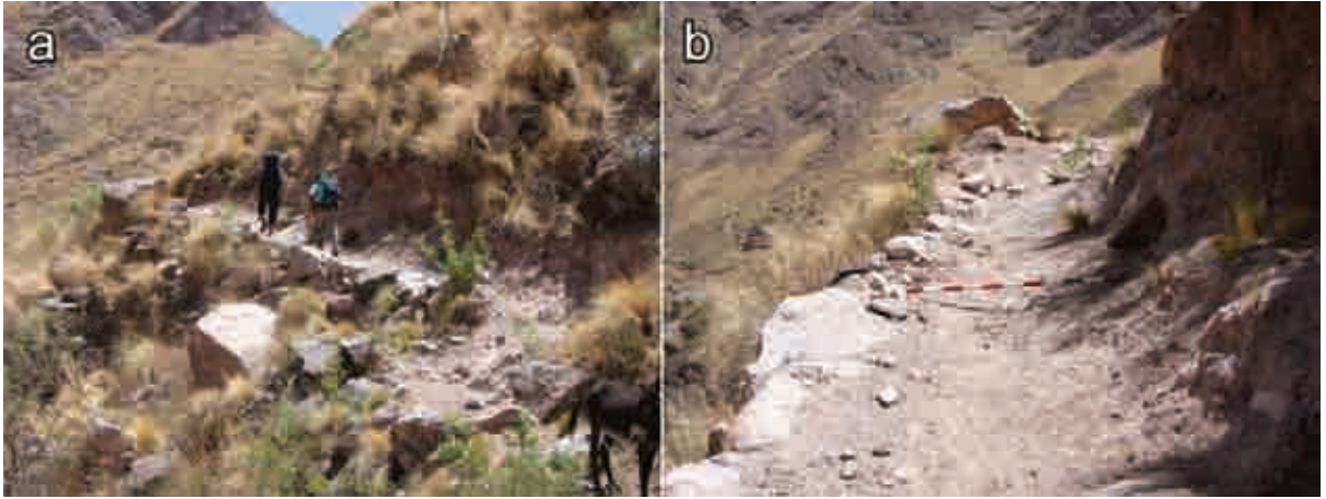
Figura VI.63: a) Camino con talud y excavación; b) El esquema general de disposición de los elementos corresponde al mismo de la Figura VI.19, pero en este caso sin la presencia de un muro de protección por encima del talud. Fotografías del autor.
