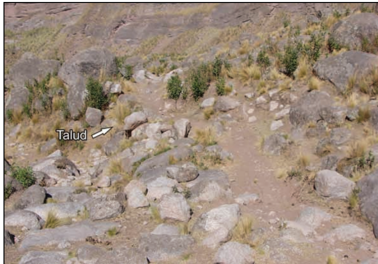
Figura VI.94. Camino con talud o muro de contención sobre superficie eluvio-eólica (Altura: 2626 msnm). Fotografía del autor.
