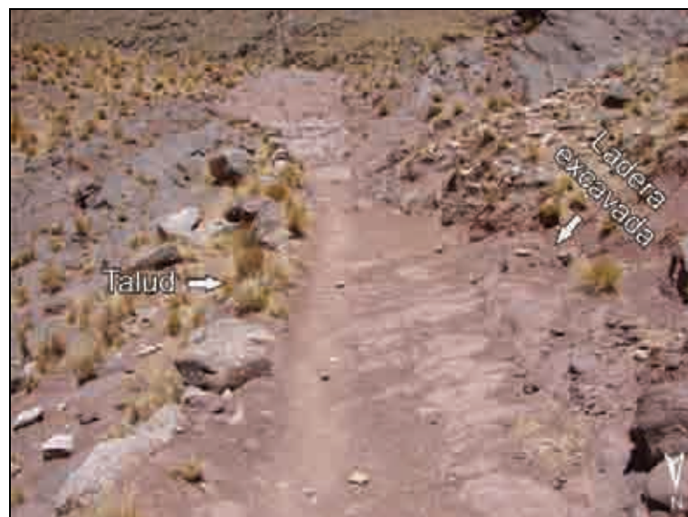
Figura VI.133. Obsérvese el talud sobre el borde ladera abajo en relación con la excavación sobre el borde ladera arriba. Fotografía del autor.
