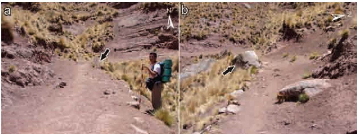
Figura VI.137. Ascenso al Abra de La Calera. Camino con talud y excavación. Las flechas indican las piedras en posición vertical a la vera del camino. Fotografías del autor.
