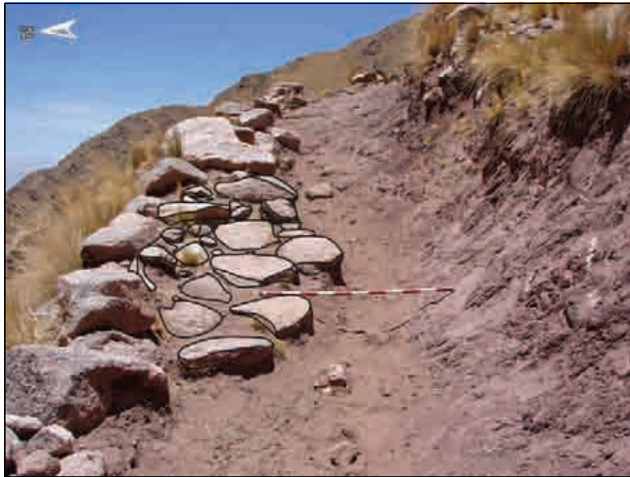
Figura VI.140. Camino tipo empedrado. Las rocas marcadas corresponden al empedrado de la superficie del camino. Fotografía del autor.
