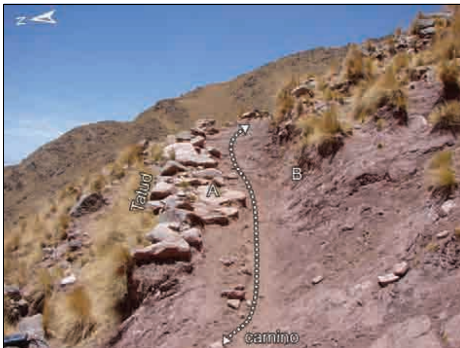
Figura VI.141. Camino tipo empedrado: A= sector empedrado; B= sector excavado de la ladera. El camino indica la circulación actual, posiblemente cubierta por el empedrado en algún tiempo pasado. Fotografía del autor.
