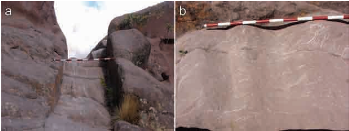
Figura VI.101: a) Peldaños y borde de la vía labrados sobre la roca madre; b) Detalle de los escalones. Fotografía del autor.
