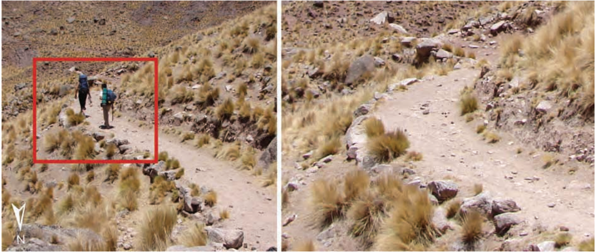
Figura VI.135. Obsérvese el detalle de la construcción del talud sobre la curva.
