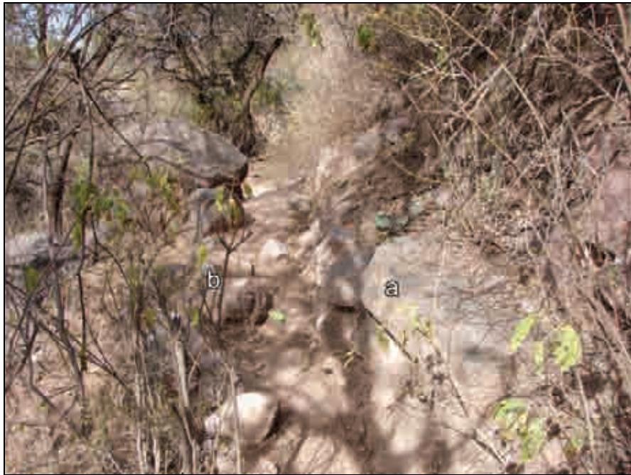
Figura V.64: a) muro de contención sobre el borde del camino ladera arriba; b) alineamiento superficial contiguo sobre el borde ladera abajo.
