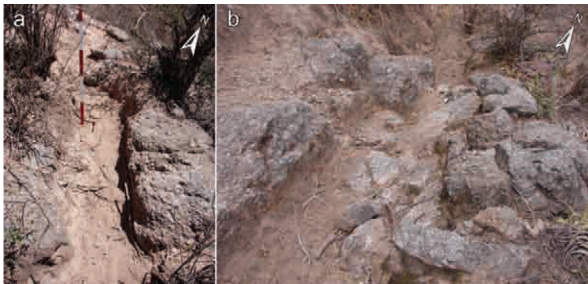
Figura V.78: a) Trabajo sobre la roca demarcando el borde derecho -ladera abajo-; b) Trabajo sobre la roca demarcando el borde izquierdo -ladera arriba-. Fotografías del autor.
