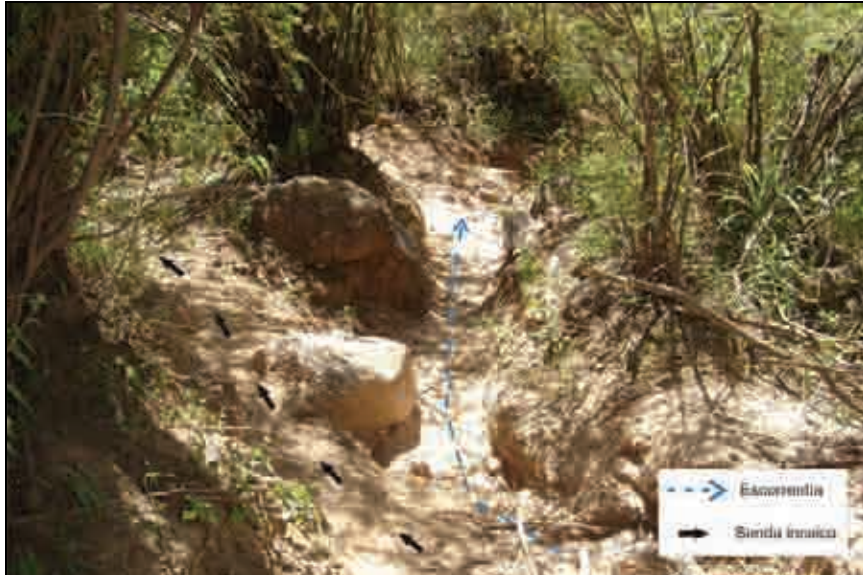
Figura V.17. Vía afectada por la formación de pequeños arroyos. Fotografía del autor.
