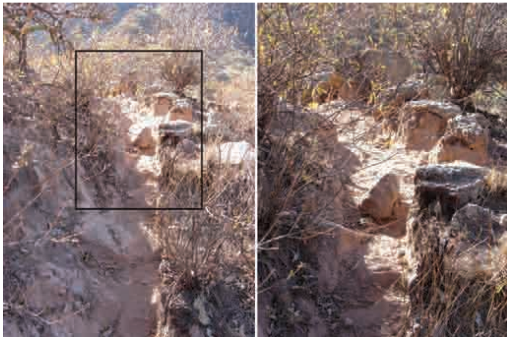
Figura V.74. Obsérvese la alineación contigua de rocas sobre el borde externo del camino -ladera abajo- (sector derecho de la imagen) y el corte de la ladera sobre el borde interno del camino -ladera arriba- (sector izquierdo de la imagen).
