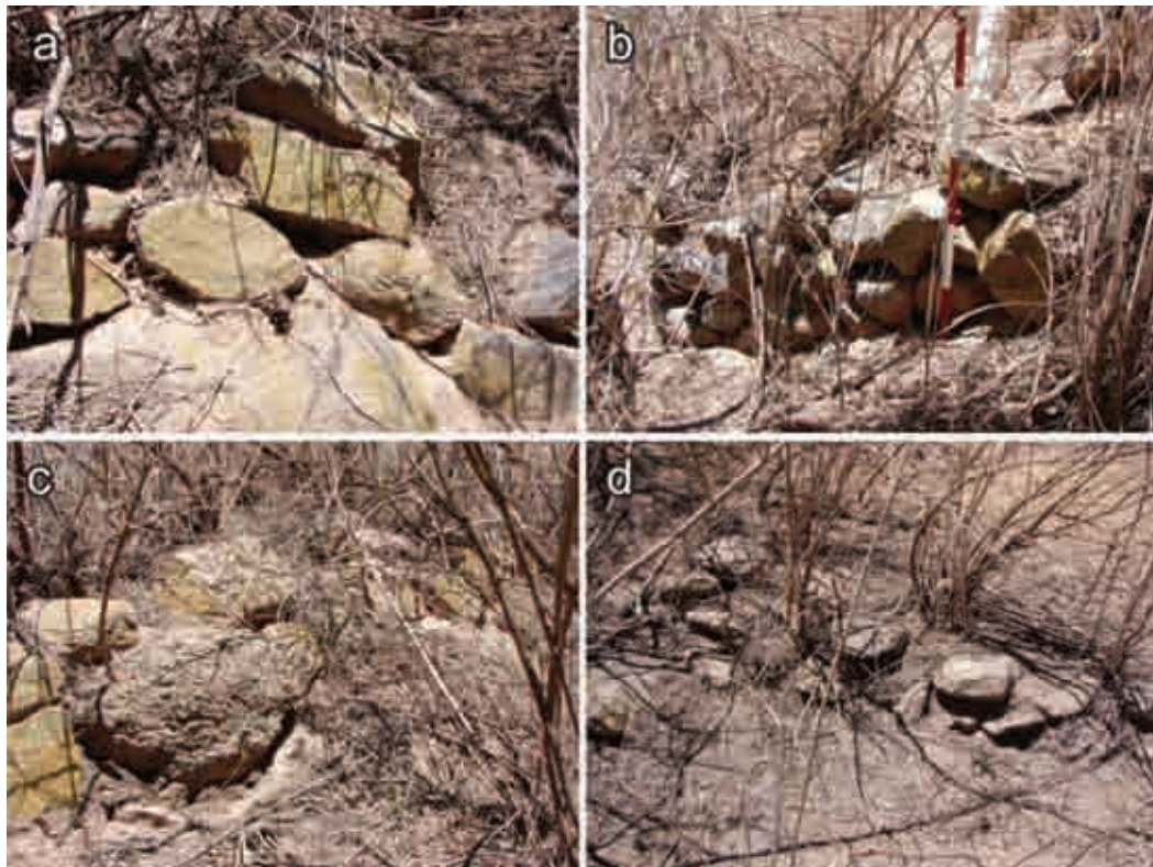
Figura V.85. Configuración arquitectónica del exterior de los muros de contención. Fotografías del autor.
