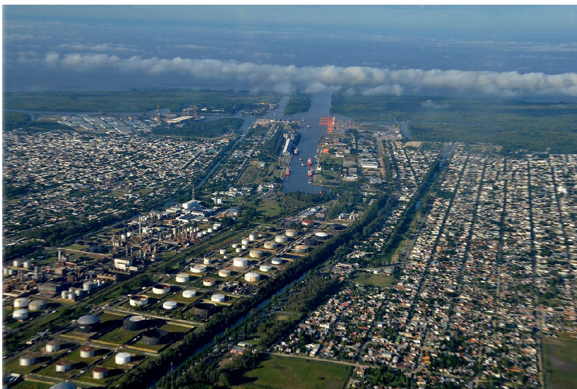
Refinería YPF La Plata. Foto: < www.nuevoambiente.org >
