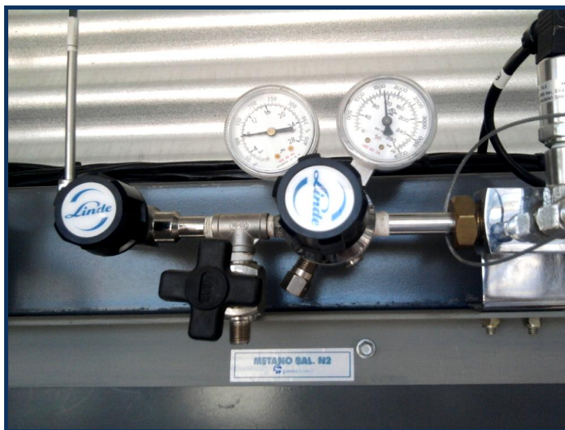
- Figura 13 (de derecha a izquierda, en el sentido de circulación de los gases): Válvula de seguridad y control de presión, llave de purga de seguridad y válvula de control de suministro de gas hacia el laboratorio. Debido a que los tubos de suministro se encuentran en un área de seguridad destinada exclusivamente a los mismos, los gases son transportados hacia el laboratorio por medio de conductos internos.-
