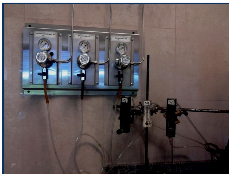
- Figura 13 (de derecha a izquierda, en el sentido de circulación de los gases): Válvula de seguridad y control de presión, llave de purga de seguridad y válvula de control de suministro de gas hacia el laboratorio. Debido a que los tubos de suministro se encuentran en un área de seguridad destinada exclusivamente a los mismos, los gases son transportados hacia el laboratorio por medio de conductos internos.-
