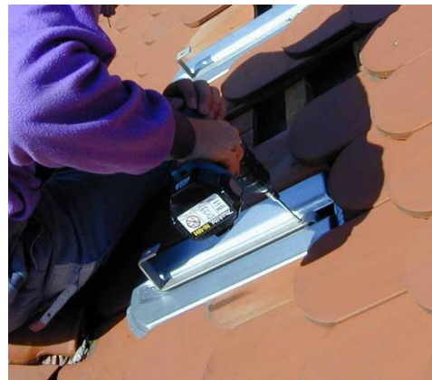
Fijación de un gancho de anclaje para tejados tipo "Biberschwanz"
