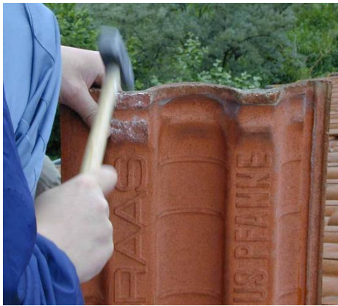
Liberar hueco para el gancho de anclaje
