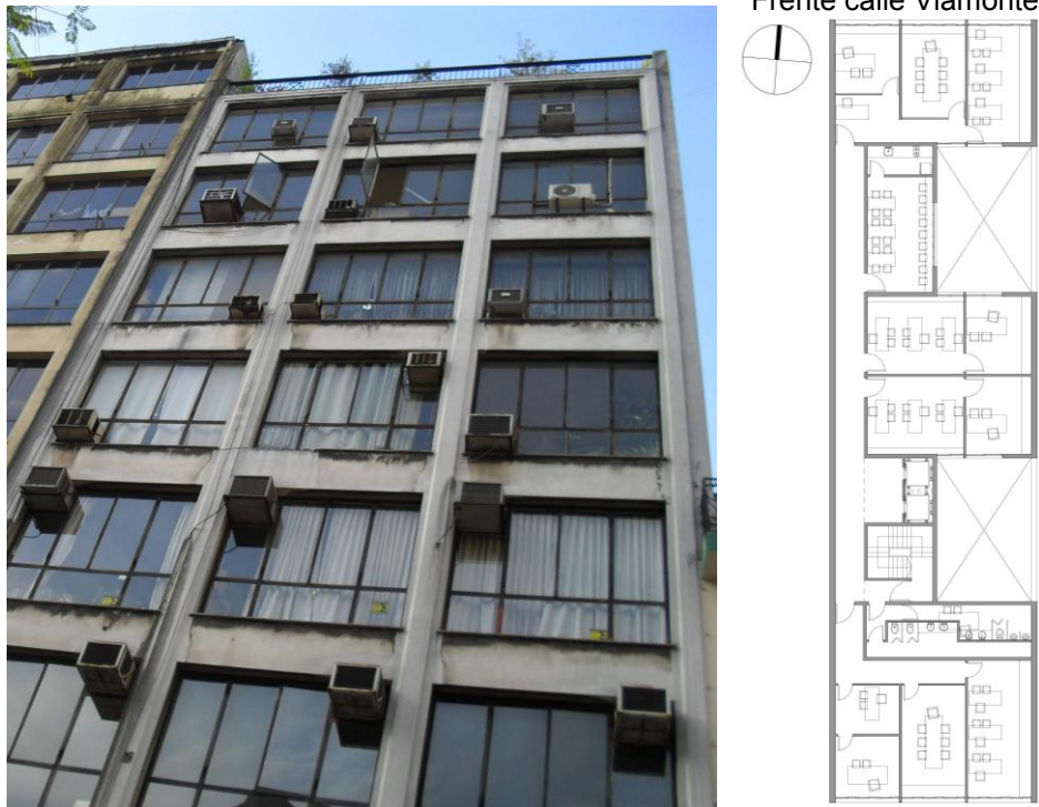
Figuras V – 31 y 32: Vista del frente y planta tipo del edificio de oficinas analizado (Caso E).
