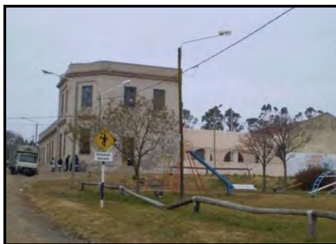
Figura 99. Escuelas Primaria N° 4 y Secundaria N° 15.
