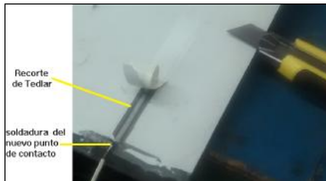
Figura 8 - Cara posterior corte del Tedlar y soldadura
