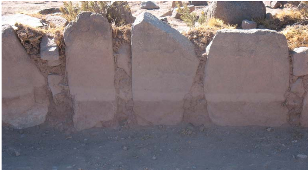
Figura 6.6. Sector sur del muro perimetral de la Estructura 1 del sitio Las Cuevas V
