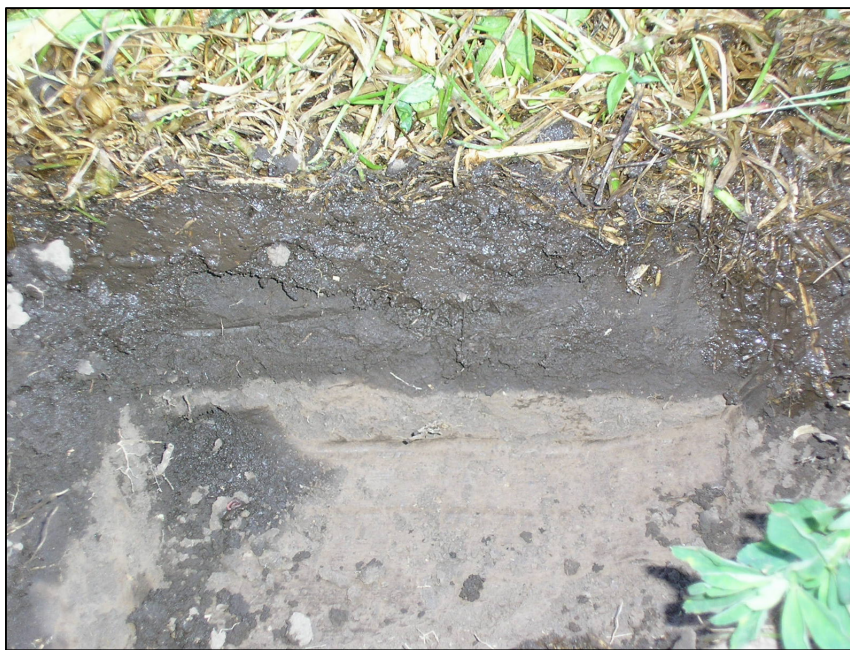
Foto 10: Compactación sub superficial
