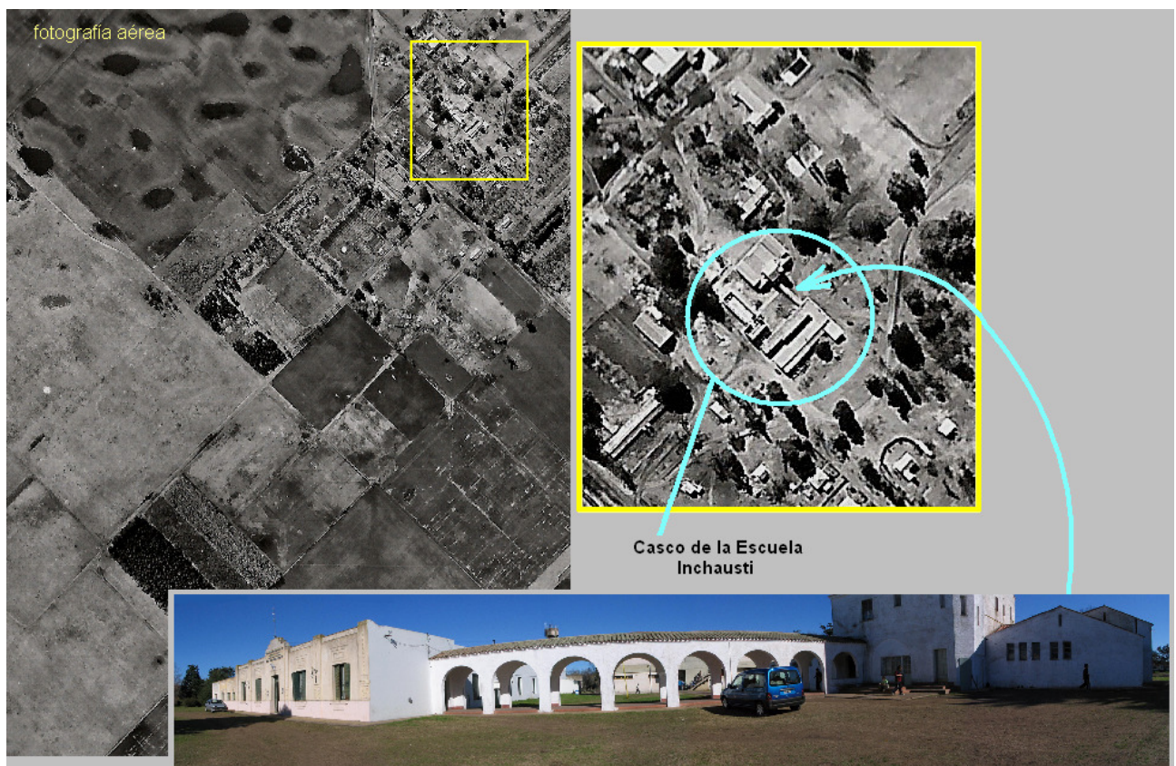
Figura 1-1. Fotografía aérea ampliada mostrando el casco de la escuela Inchausti. Abajo, foto de frente del casco de la escuela.
