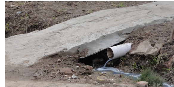
Figura 3- Registro sistema cloacal a cielo abierto-Invierno 2013. Fuente: Laboratorio Bio-Ambiental de Diseño-UFLO
