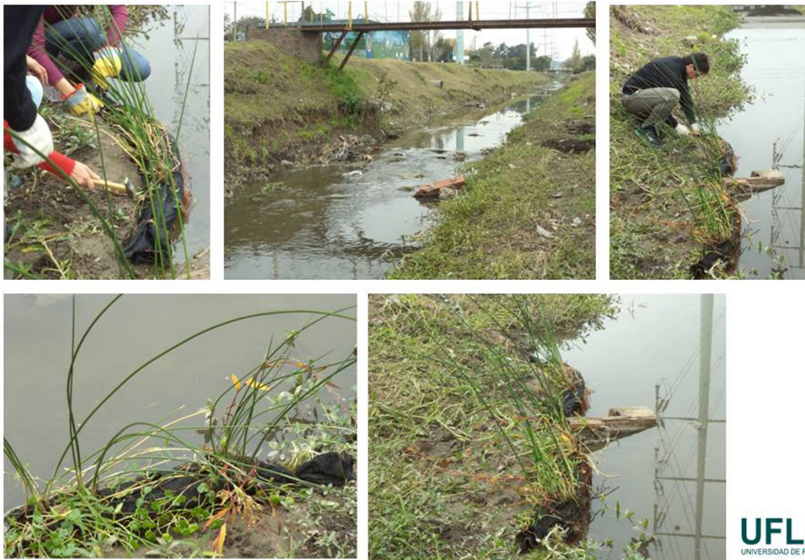
Figura 12- Plantación de bio-rollos en Arroyo Ortega (Esteban Echeverría). Fuente: Laboratorio Bio-Ambiental de Diseño-UFLO
