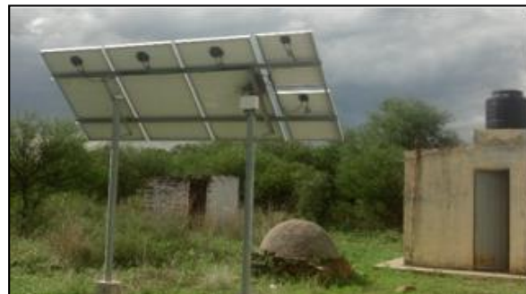
Figura 4. Panel solar fotovoltaico utilizado en el establecimiento educativo “86044”.
