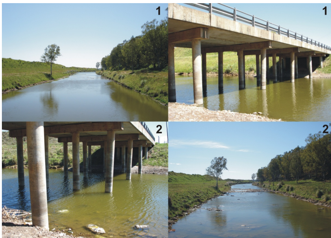
Figura 2.4: Fotografías del Canal del Este en las campañas de muestreo: 1- aguas bajas (nov. 2008) y 2- aguas muy bajas (sept. 2009).
