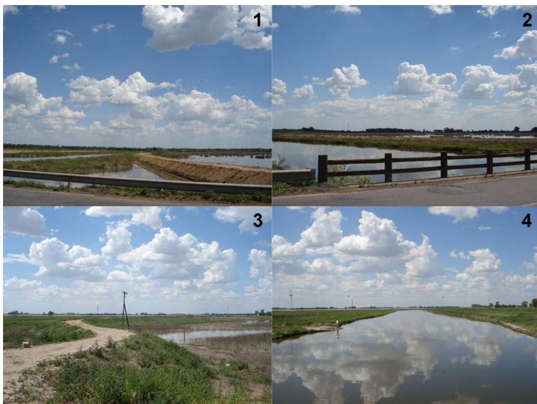
Figura 2.9: Fotografías del Canal de Vinculación en noviembre 2008 ( aguas bajas ). 1 y 2- Vista del terraplén construido aguas arriba del sitio de muestreo, nótese la interrupción del humedal (fondo). 3 y 4- Vistas hacia la laguna del Bragado (aguas abajo del sitio de muestreo), 3- terraplén construido en los márgenes y 4- ampliación del cauce del canal, luego de las obras.
