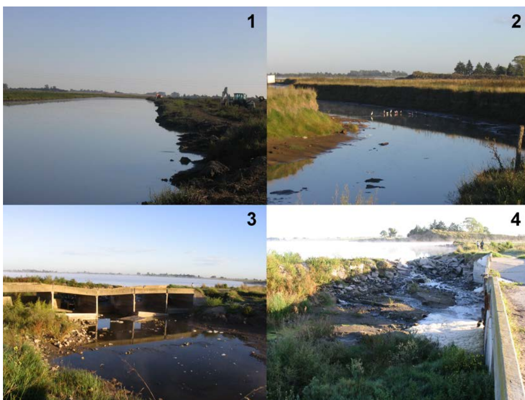
Figura 2.8: Fotografías del Canal de Vinculación y las nacientes del A o Saladillo en el muestreo de marzo 2008 ( caudales medios ). Referencias: 1- Máquinas retroexcavadoras realizando trabajos de ampliación del cauce del Canal de Vinculación, aguas abajo del sitio de muestreo. 2- Márgenes rectificadas en las cabeceras del arroyo Saladillo. 3 y 4 – Nacientes del arroyo Saladillo en la laguna del Bragado (fondo). Nótese la espuma presente debajo de la alcantarilla en 4.
