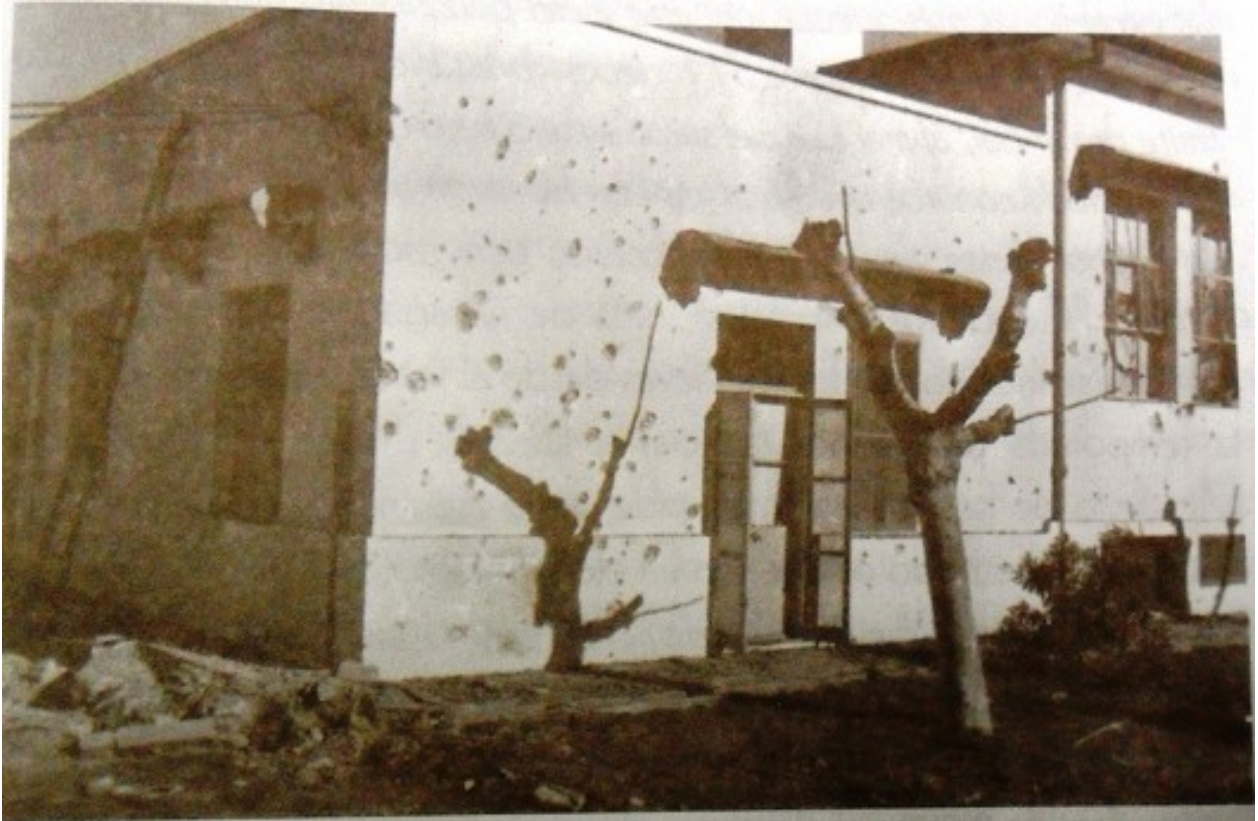
Consecuencias en la planta transmisora de los enfrentamientos entra azules y colorados 17
