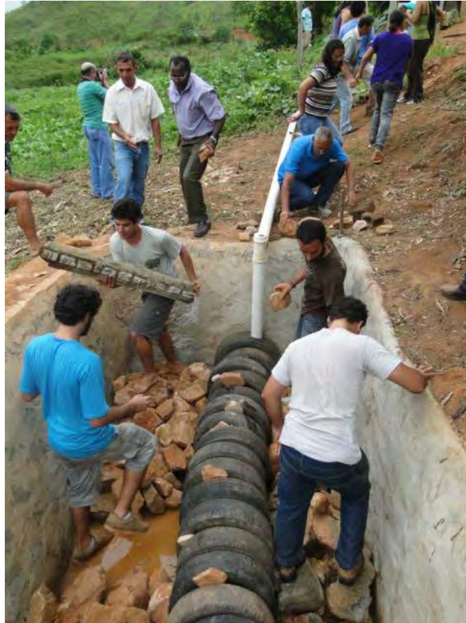
FIGURA 1. Envolvimento dos participantes no mutirão de montagem da fossa evapotranspiradora.
