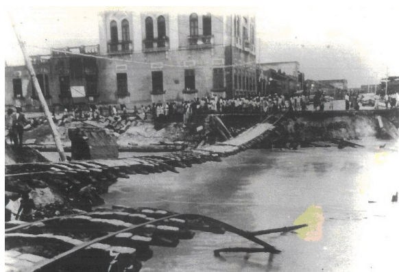
Figura 14 - Ponte sobre o riacho Maceió na Avenida da Paz após obras de retificação, nova enchente em maio 1949 gera grande catástrofe urbana. Fonte: Domínio público, 19 maio de 1949. Acesso em 2014.
