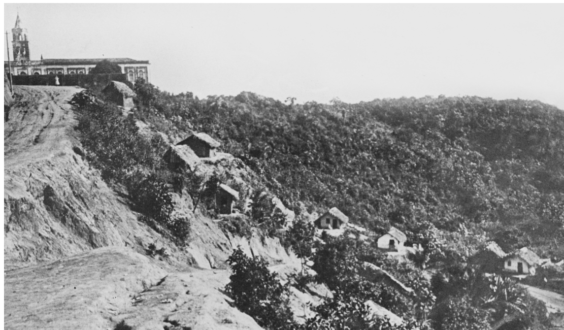
Figura 5 - Ocupação das margens do riacho Maceió no início do século XX. Fonte: Domínio público, s/d. Acesso em 2014
