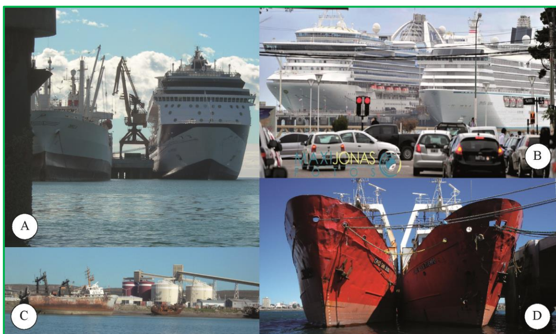
Figura 2. Zona portuaria en golfo Nuevo. (A, C): Muelle Almirante Storni -MAS-. (B, D): Muelle Luis Piedra Buena -MLP-. Fotografía (B) tomada de "Maxi Jonas Fotos".
