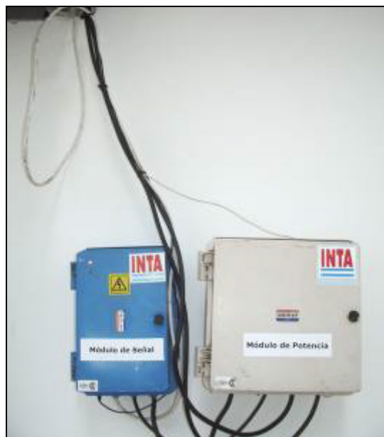
Figura 3. Vista del controlador compuesto del módulo de señal (izquierda) y de potencia (derecha).
