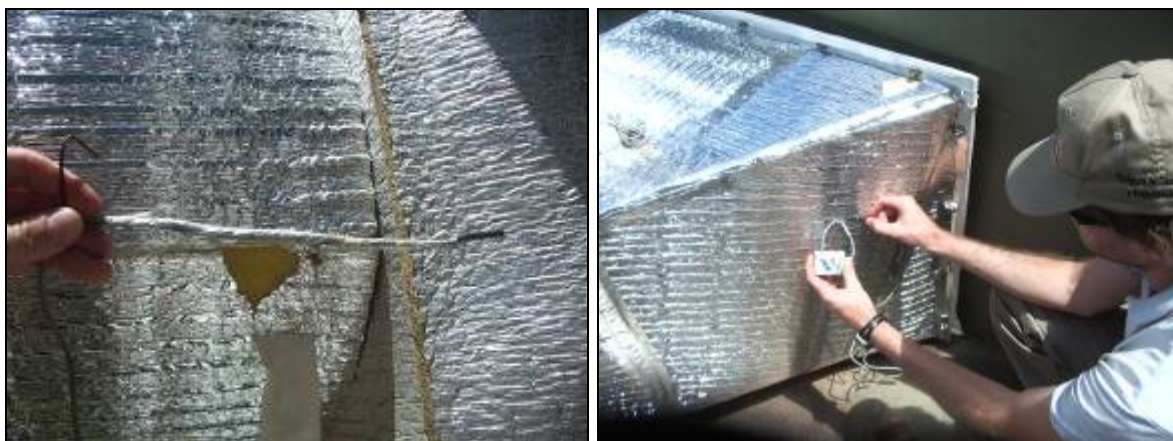
Figura 8. Izquierda: estructura de guía y armado del sensor para insertar en la transición al silo. Derecha: colocación de sensores en la transición al silo.
