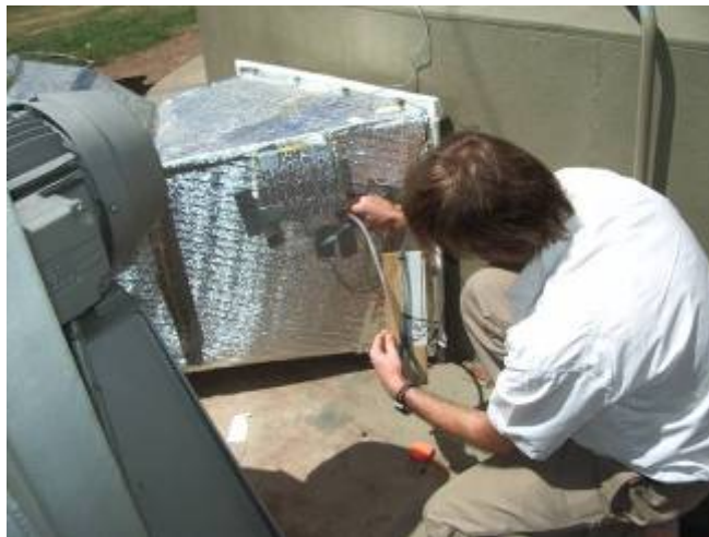
Figura 10. Medición de la presión estática dentro de la transición que conecta el equipo de frío al silo.
