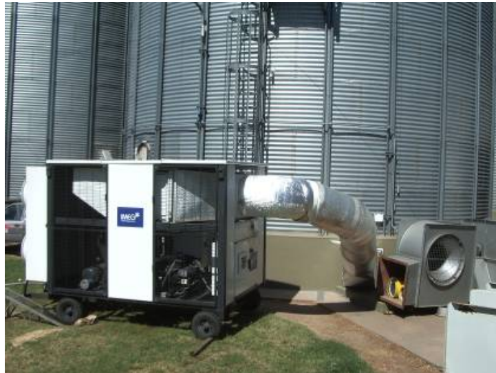
Figura 6. Vista de la conexión entre el equipo de frío y el silo con 1.184 toneladas de trigo.
