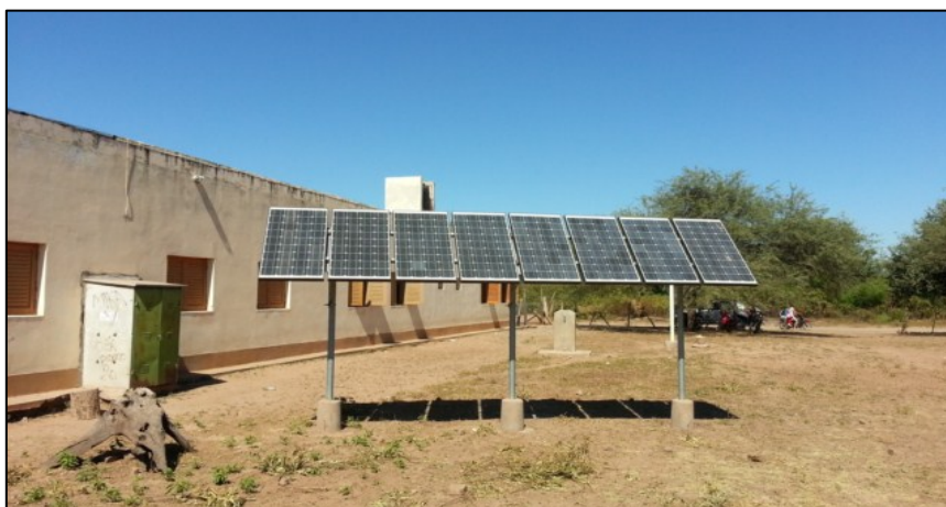
Figura 3.2. Energía solar en Escuela N° 348, Dpto. Pellegrini, Pvcia. Santiago del Estero (Herrera et al., 2014-a).
