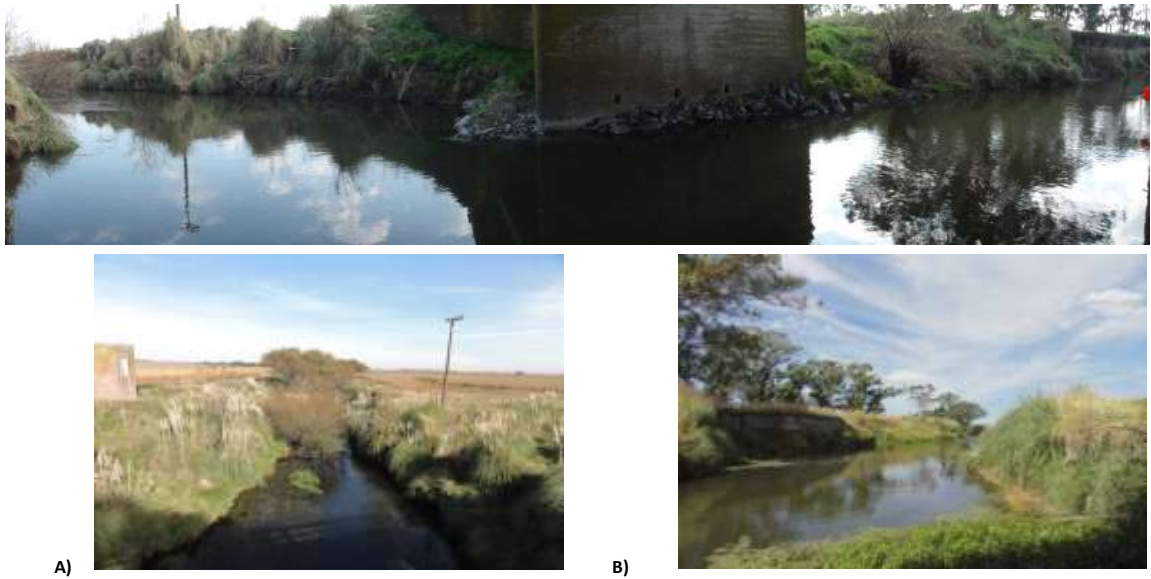
Figura 3.3: Sitio 1: Vista general (imagen superior); vista aguas arriba (imagen inferior A) y aguas abajo (imagen inferior B).
