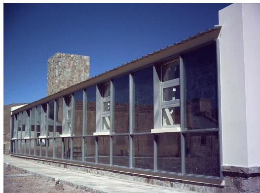
Figura 2.11: Muro Trombe en el Hospital de Susques, Jujuy. Fuente: Hernández (2012)
