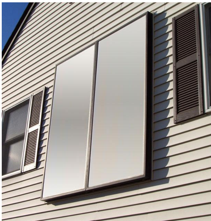
Figura 2.21: Instalación de equipos de calefacción solar por aire. Fuente: SunMate Solar Panels (2015)
