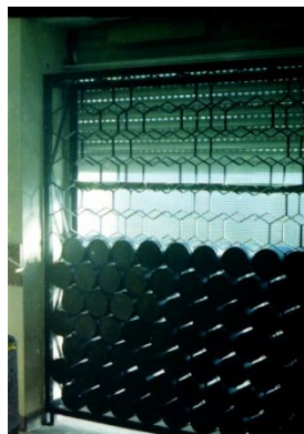
Figura 2.12: Muro acumulador de agua el prototipo solar de La Plata. Fuente: Dr. Carlos Discoli
