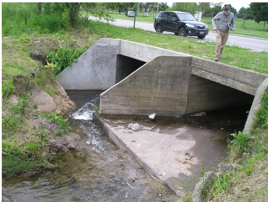
Foto 3-1: Embocadura del conducto derivador de 143 (Tramo II).
